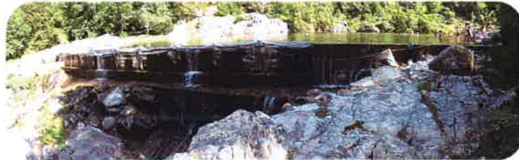
Aménagement d'un seuil amovible pour la baignade
